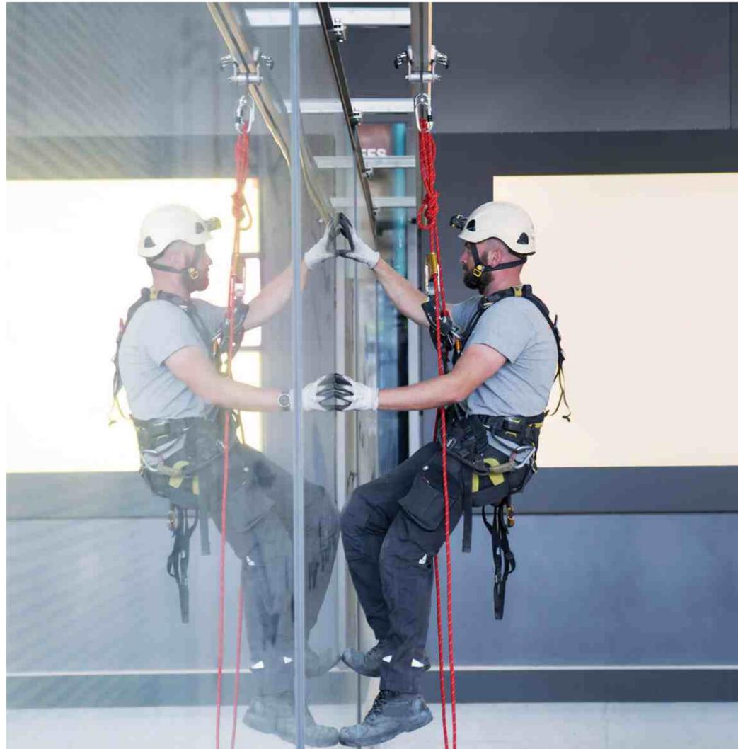
Die SafeAccess Schiene für seilunterstützte Arbeiten bietet eine effiziente Lösung für die Reinigung und Wartung der Fassaden.
