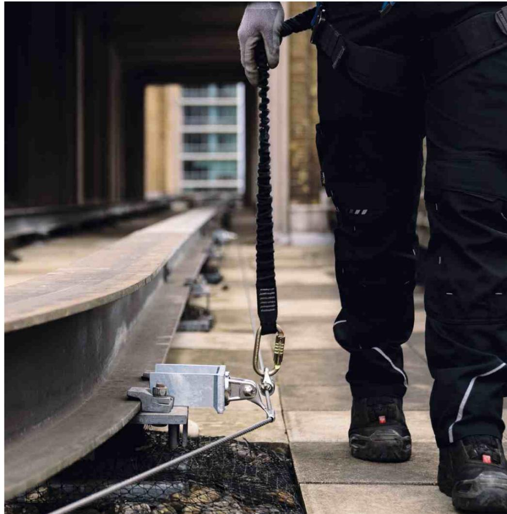
Horizontale SecuRope 2012 Seilsicherung direkt auf Betonstruktur montiert
