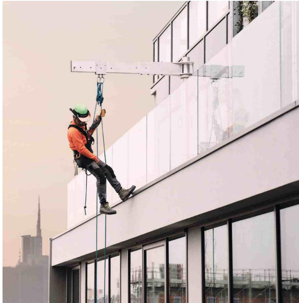
Abnehmbarer Davit, der einem Arbeiter die Durchführung von Wartungs- oder Reinigungsarbeiten an einer Fassade ermöglicht. Der Davit kann von einem Seilzugangsspezialisten oder von einem RopeClimber-Benutzer verwendet werden. Der Davit wird mittels Konsolen, die fest am Gebäude installiert sind, auf dem Dach installiert. Am Ende der Arbeiten wird der Davit demontiert und gelagert.
